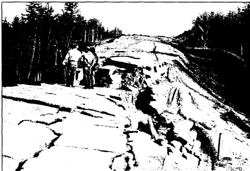
Рис. 9.9. Разрушенные мост и автодорога. Нефтегорское (Сахалин) землетрясение 28 мая 1995 г.; 8–9 баллов, магнитуда 7,5, глубина очага 15–20 км (Семенов, Павленов, 1996)
