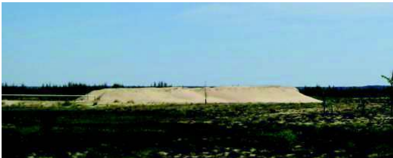
Рис. 2.6.5 Факельный амбар куста газовых скважин, подвергшийся эоловому процессу
