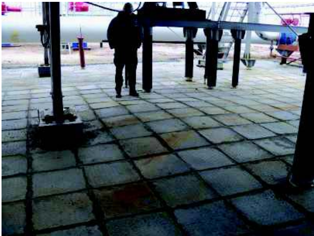
Рис. 4.3.3 Миграционный бугор пучения (тип II) в июне
